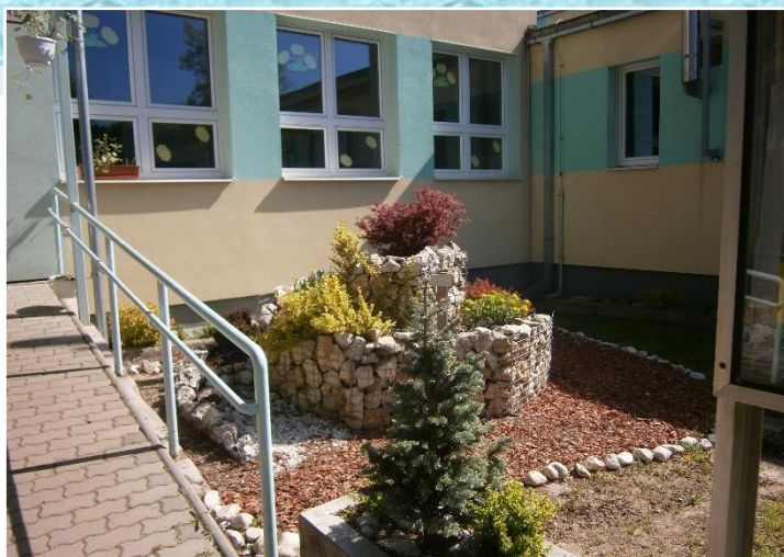
Gabion, ktorý je zavlažovaný dažďovou vodou
